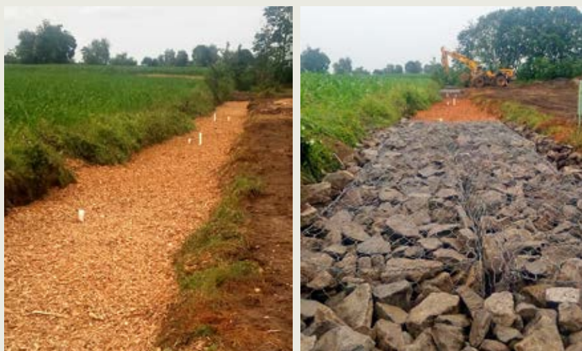
Aanleg van de bioreactor in juni 2018. De houtsnippers worden gestabiliseerd met keien.
