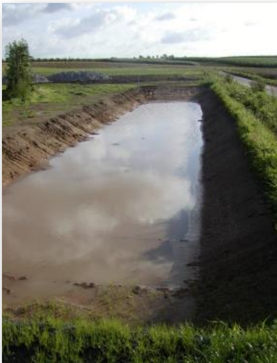
Figuur 5. – Voorbeelden opvangsystemen onderaan een perceel.
