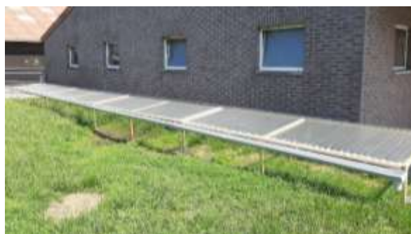
Figuur 10: Bovenstaande foto is een eenvoudige inrichting van een geschikte vul- en spoelplaats. Het golfplaatdak met afloop zorgt voor de opvang van het intern spoelwater. Het spruitstuk rechts aan de afloop kan gekoppeld worden aan de al dan niet ondergronds geplaatste opvangcontainer waaruit gepompt kan worden naar een zuiveringstelsel. Door het golfplaatdak opklapbaar te maken wordt regenwater verhinderd in de opvangcontainer te lopen.
