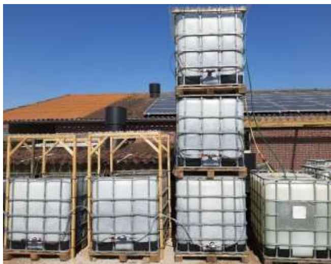
Figuur 13: Rechts van de budgetversie van de gebouwde biofilter staat een opvangbak voor restwater. De bedoeling is dat het restwater verzameld in het ingegraven vat aan de vul- en spoelplaats met een simpele dompelpomp regelmatig wordt overgepompt naar dit opvangvat net naast de biofilter. In principe is dit extra opvangvat niet nodig, en kan er rechtstreeks van de opvang aan de vul- en spoelplaats in de biofilter worden gepompt. Dit vat staat er als extra controle en als extra visuele controle en sensibilisatiemogelijkheid en is niet meegeteld in de financiële berekening.
