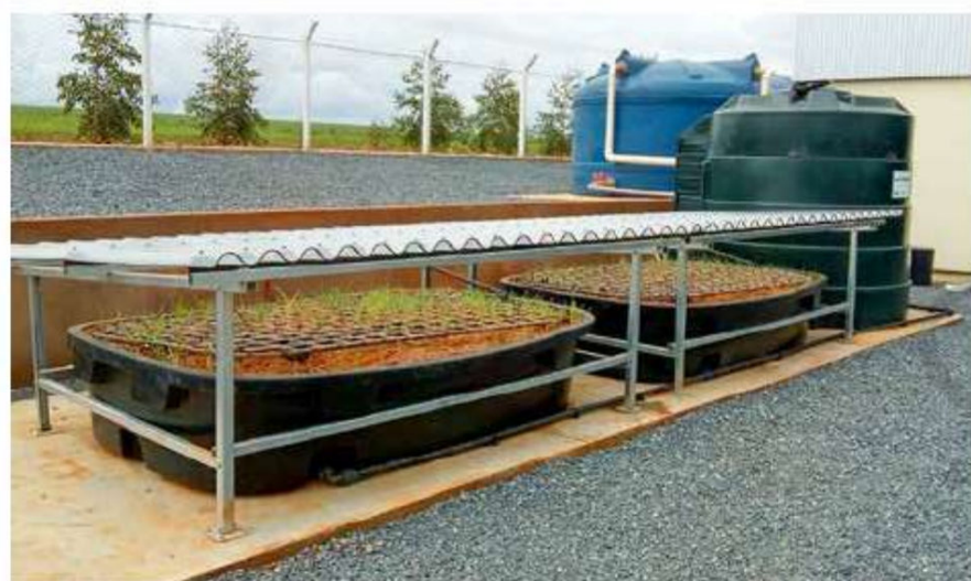
In deze opbouw werd het fytobakprincipe toegepast. De bovengrondse opvangciterne rechts voorziet de bakken van restwater via het buizenet op de bakken. De buizen onderaan de bakken draineren het overtollige water terug naar de opslagtank.
