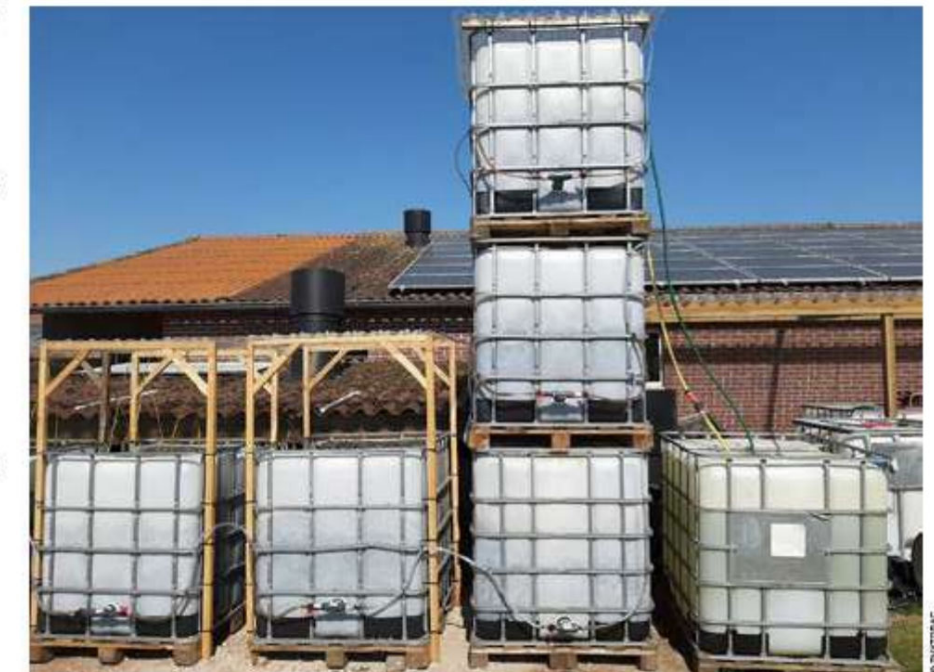
Resultaat na de opbouw van een biofilter. In dit geval wordt er opgepompt vanuit een bovengrondse IBC vat met een pomp.
