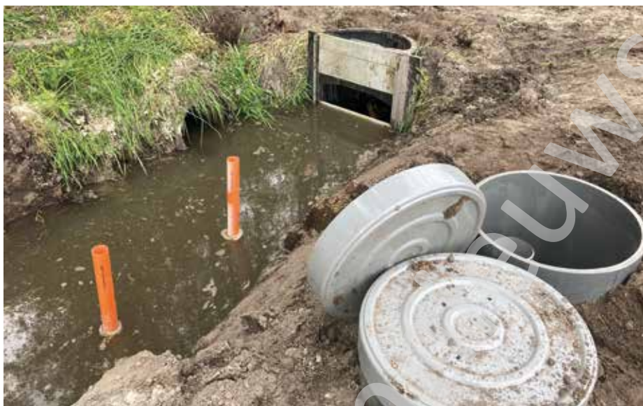
Regelbare stuw op een perceelsgracht. Stroomopwaarts van de stuw is de waterstand in de gracht hoger dan stroomafwaarts, het overtollige water stroomt nog steeds weg.
